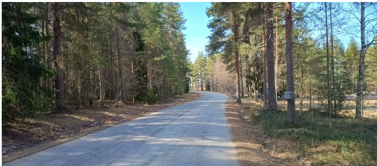
Kuva 8. Mikroaaltolaskin asennetaan tien sivuun, jolloin asennustyö voidaan tehdä turvallisesti ja asennus ei häiritse liikennettä.
